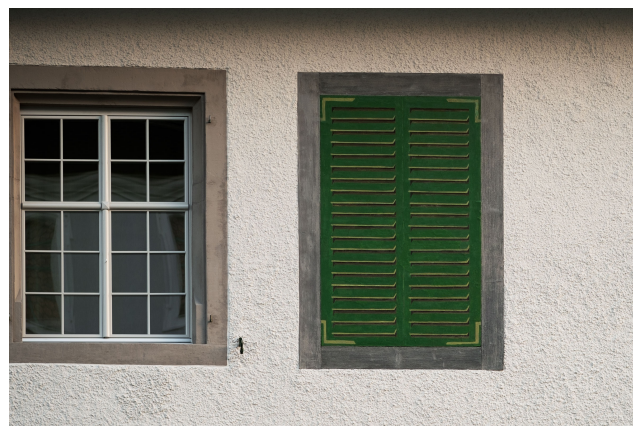
Die Illusionsmalerei ist fertig restauriert und die Fassade neu gestrichen.
