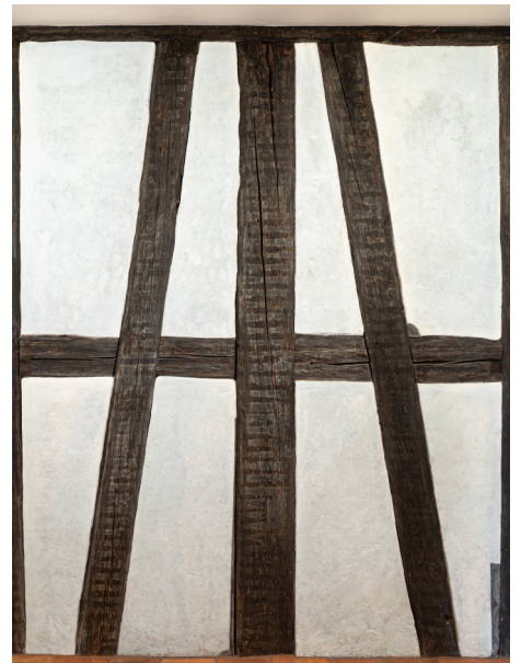
Schlussaufnahme Raum 1.01, Detailsicht der südwestlichen Wand (Foto Simon Meyer).
