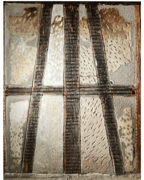
Die Fachwerkwand zeigt viele Hacklöcher auf. Tiefere Fehlstellen wurden zuerst mit einem groben Kalkmörtel vorgefüllt.
