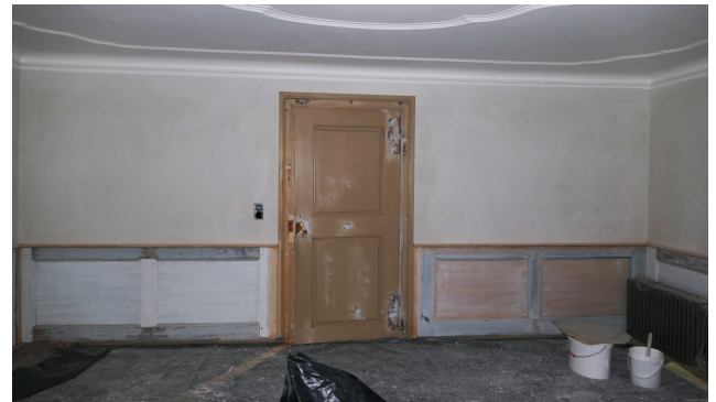
Zwischenzustand des Kniestäfers, nach Reparatur durch Schreiner und Überarbeitung durch Maler.
