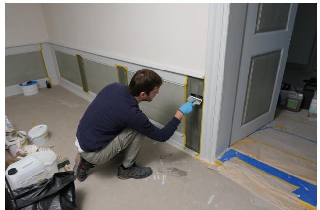
Der Restaurator fügt der aufgetragenen Ölfarbe mittels eines Borstenpinsels eine wellige Struktur zu.
