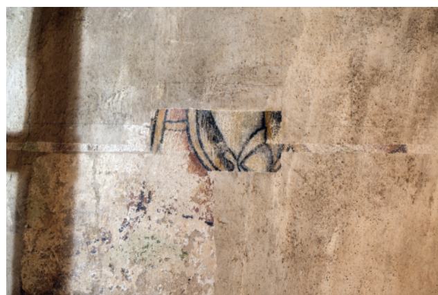
Ostwand. Eine Sondage macht eine polychrome Malerei sichtbar.
