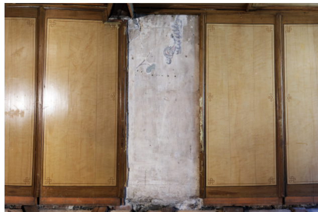
Vertäfelung Ostwand, durch früherer Eingriff teilweise entfernt. Sondierungen zeigen Teile einer polychromen Malerei.
