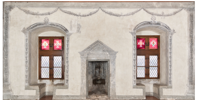
Südwand mit Grisaille-Malereien im Rittersaal (Vorzustand).
