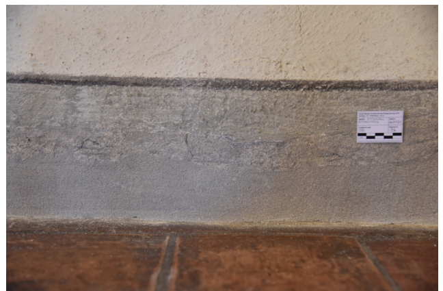
Der Sockelbereich nach der Putzergänzung und anschliessender Retusche.
