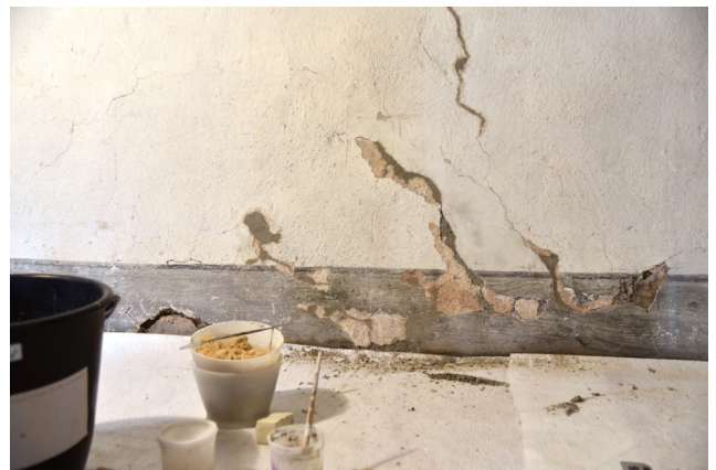
Fehlstellen und Risse im Putz wurden mit Kalkmörtel gekittet und anschliessend retuschiert.
