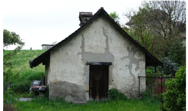
Ostfassade Waschküchen, Zustand April 2020.
