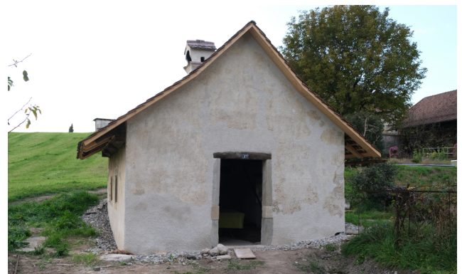
Ostfassade Waschküchen, Zustand nach der Restaurierung.
